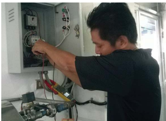
รูปที่ 77 การตรวจสอบค่ากระแสไฟฟ้า ของมอเตอร์พัดลมดูดอากาศ
