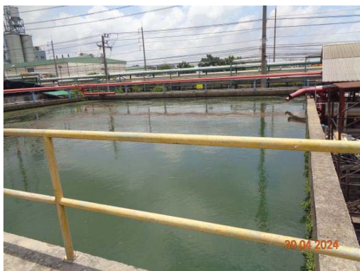
รูปที่ 39 บ่อสำรองน้ำดับเพลิง
