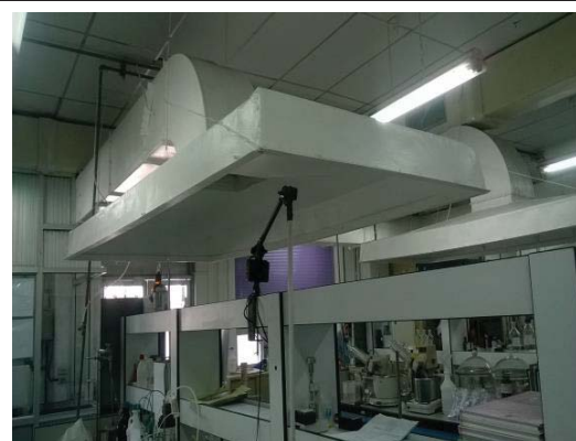
รูปที่ 45 ระบบดูดควันในห้องปฏิบัติการ
